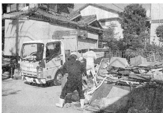
住宅地での運搬作業
