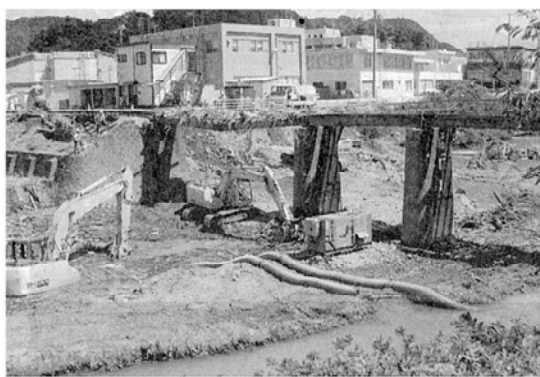
三重県紀宝町での作業
