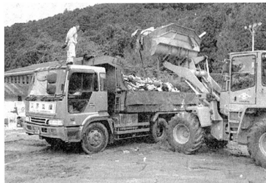
産廃協による撤去作業
