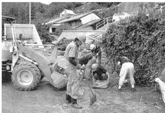
道路に溜まった土砂の積み込み作業
