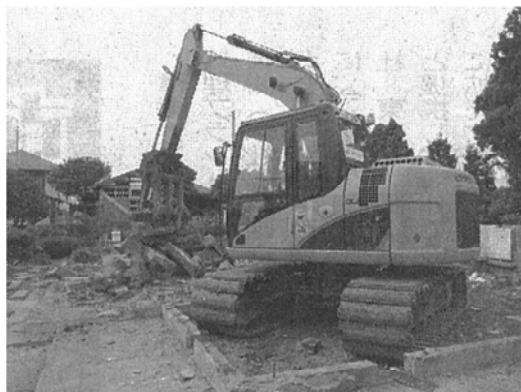
仙台市内の損壊家屋の撤去現場
